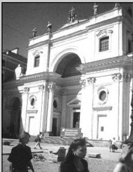
Kościół Katolicki na Newskim prospekcie w Sankt-Peterburgu w trakcie restauracji. Foto K. Ławrynowicz.
